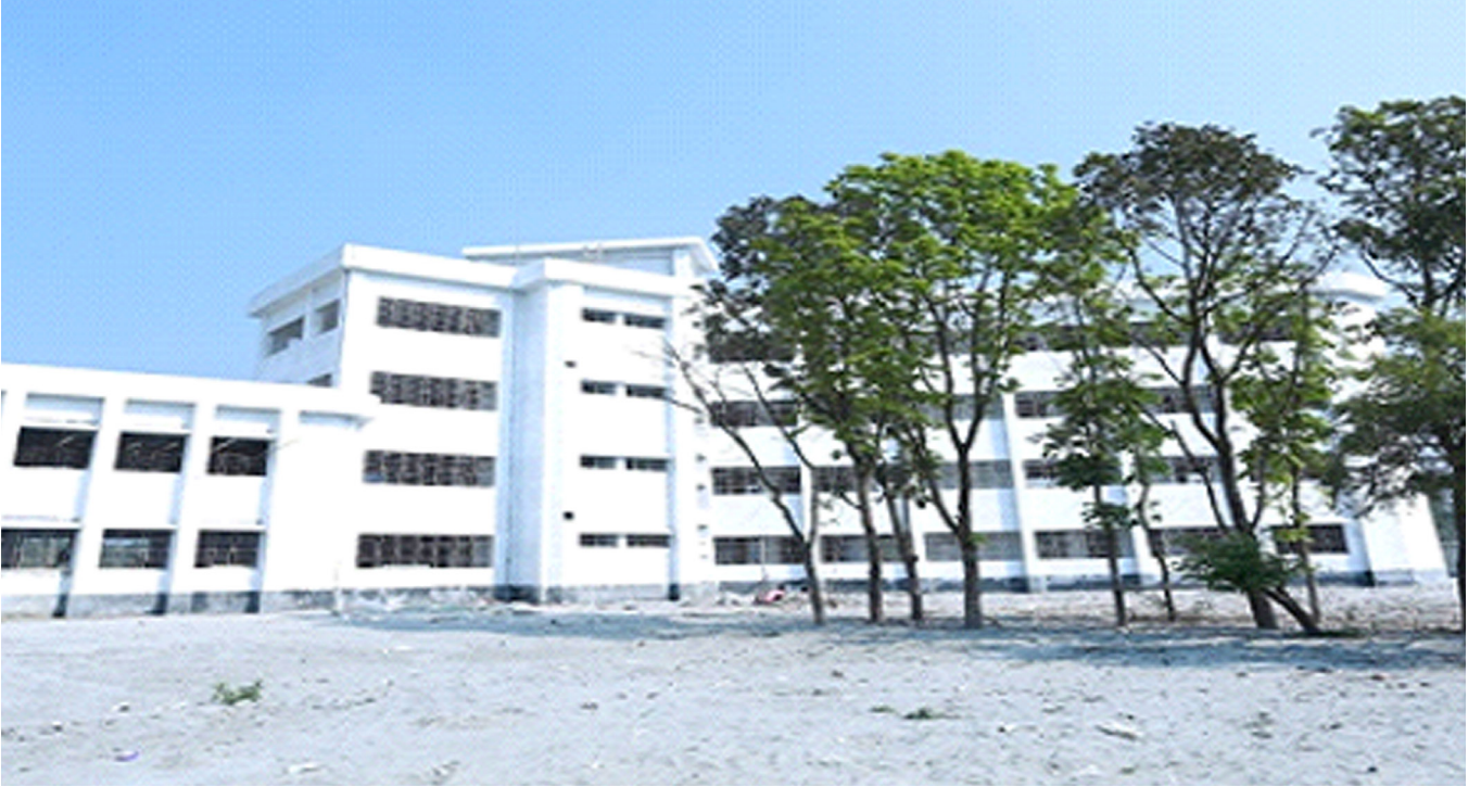
নির্মাণাধীন মানিকগঞ্জ আঞ্চলিক জনসংখ্যা প্রশিক্ষণ ইনস্টিটিউট (আরপিটিআই) নির্মাণে: স্বাস্থ্য প্রকৌশল অধিদপ্তর
